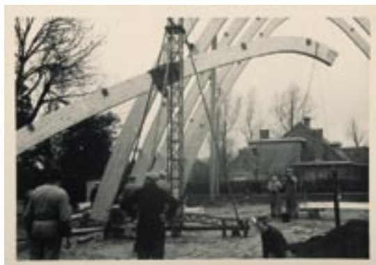
Arbeiders van De Coene op de werf van een spantenconstructie, na 1952 ARCHIEF WILLY DELAERE
